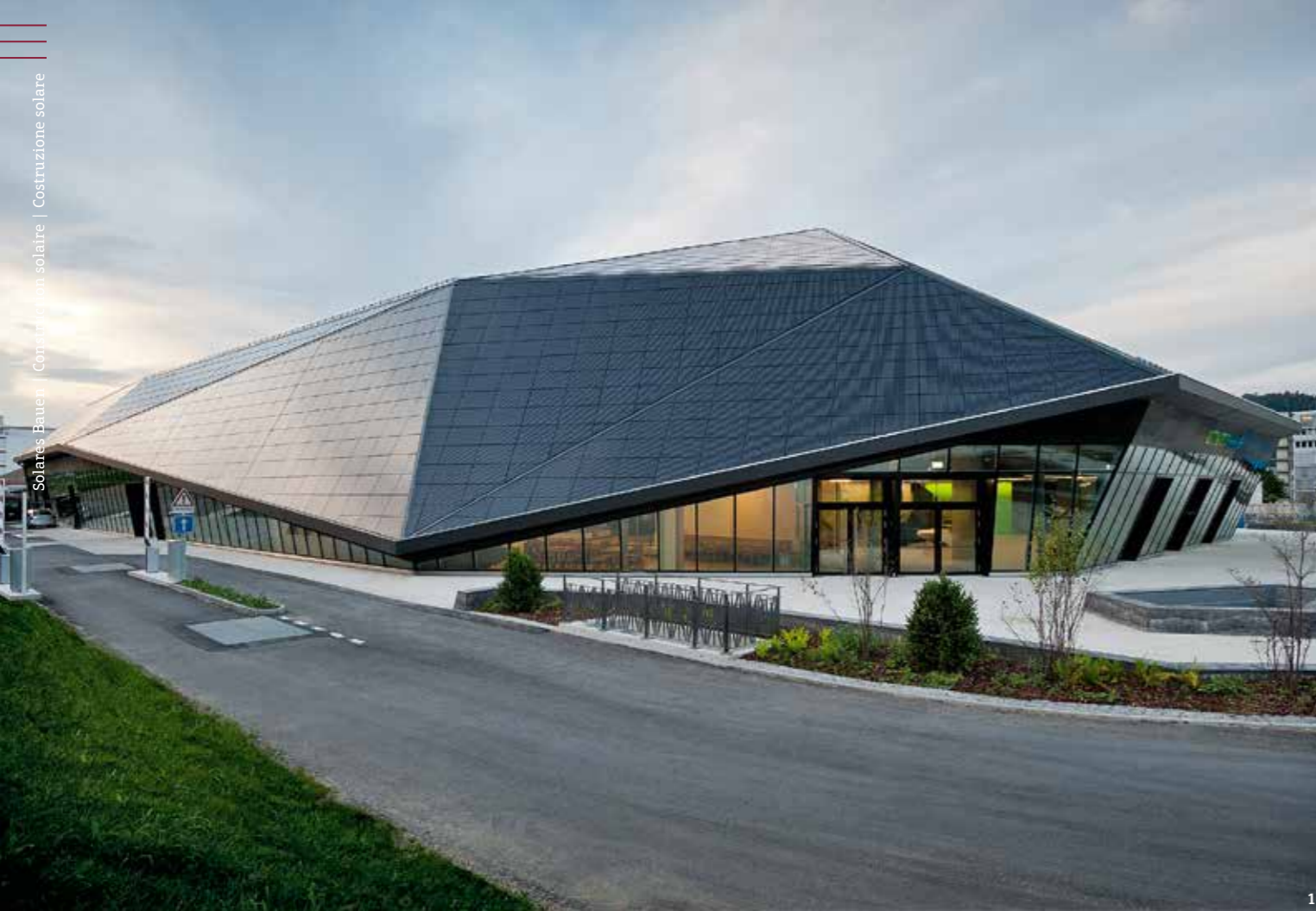
Foto: Michael Egleff © René Schmid Architekten
